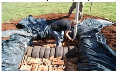
Figura B – Preenchimento com entulhos e instalação da tubulação de inspeção;
