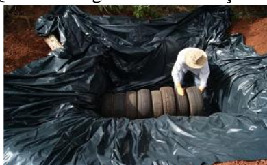
Figura A – Escavação, impermeabilização com lona plástica e tubulação com pneus usados;
