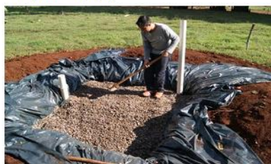
Figura D – Preenchimento com pedra brita;
