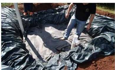
Figura C – Instalação da manta geotêxtil;
